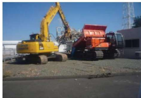
仮置き場設置作業
