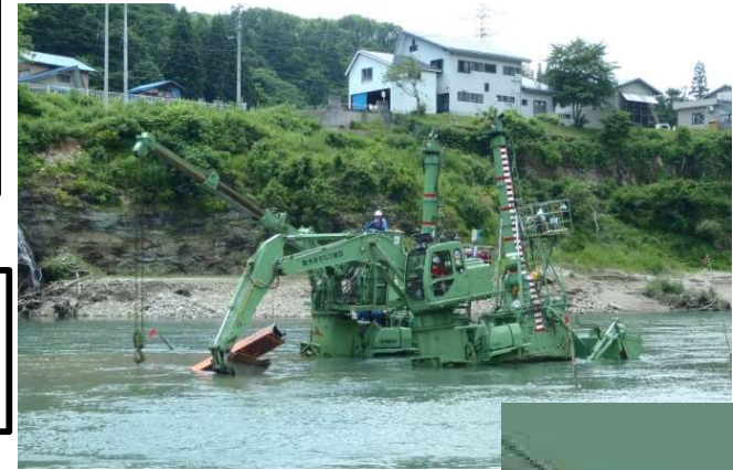
重機による水中作業等
