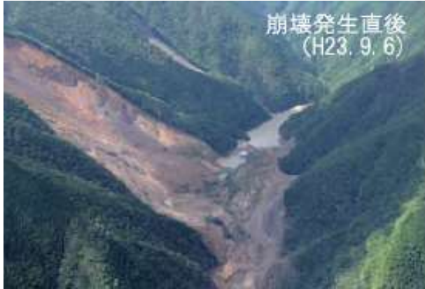
平成23年 台風12号災害 奈良県 赤谷地区
