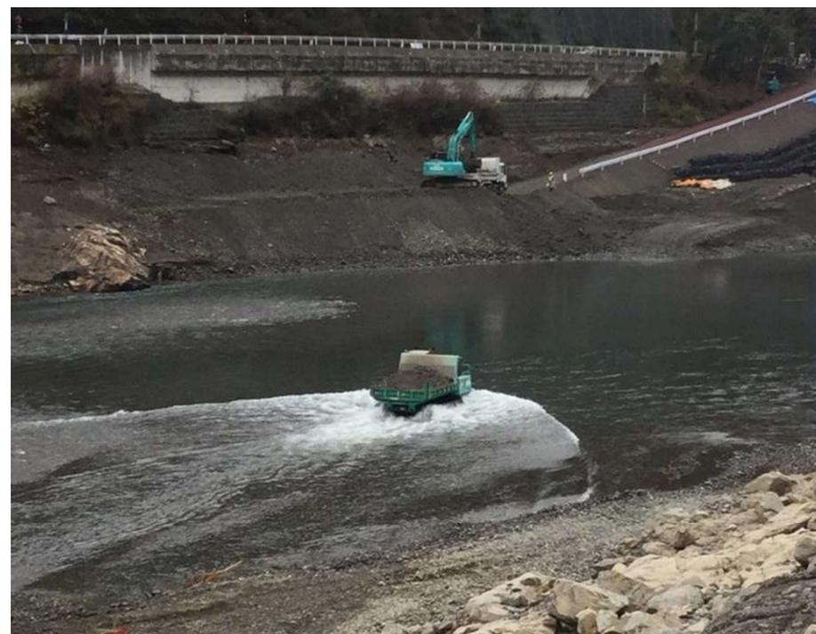
プロトタイプ1号機を用いた球磨川の堆積土砂掘削・運搬実験
