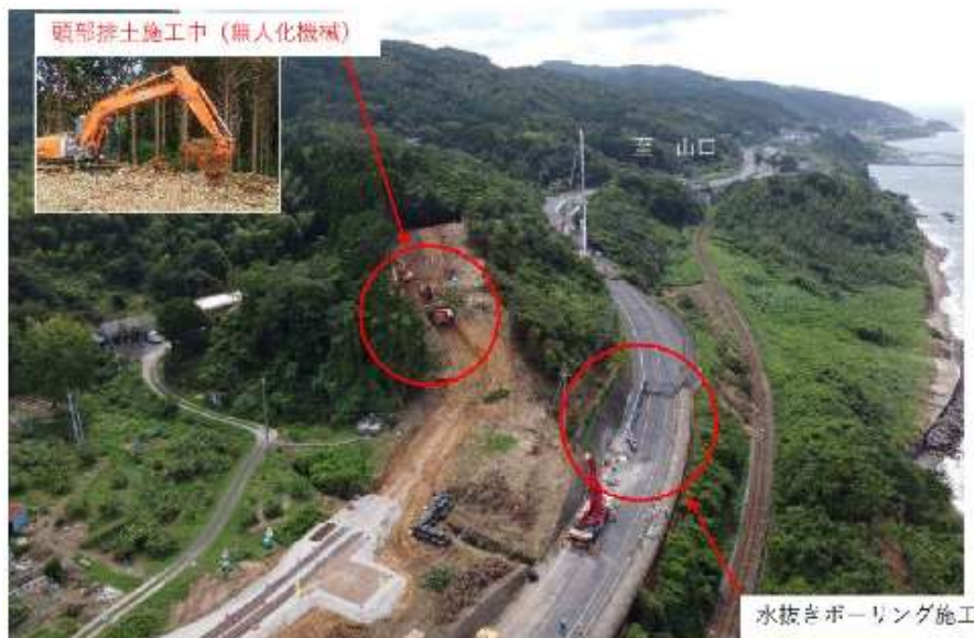
地すべり発生後8日目の頭部排土の無人化施工 (松江国道事務所)
