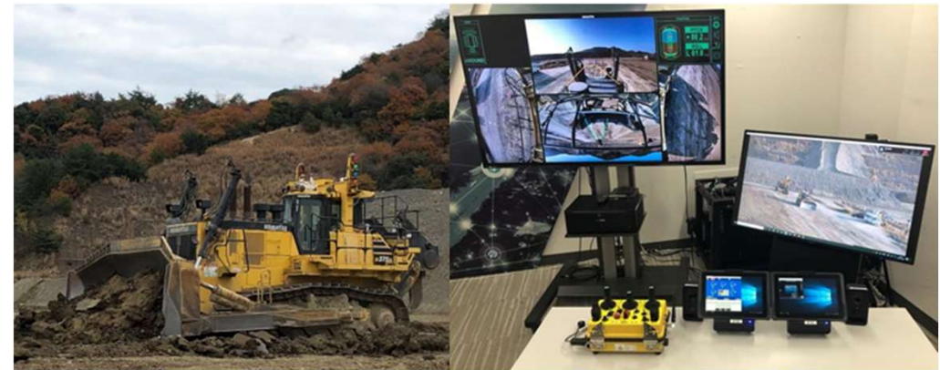
図2-2 複数の高解像度カメラ、低遅延映像圧縮装置、大型ICTブルドーザー、マルチモニター、マシンガイダンスモニター (NTTドコモ、株式会社小松製作所／商用5Gによる鉱山向け大型ICTブルドーザー遠隔操作の実証実験)
