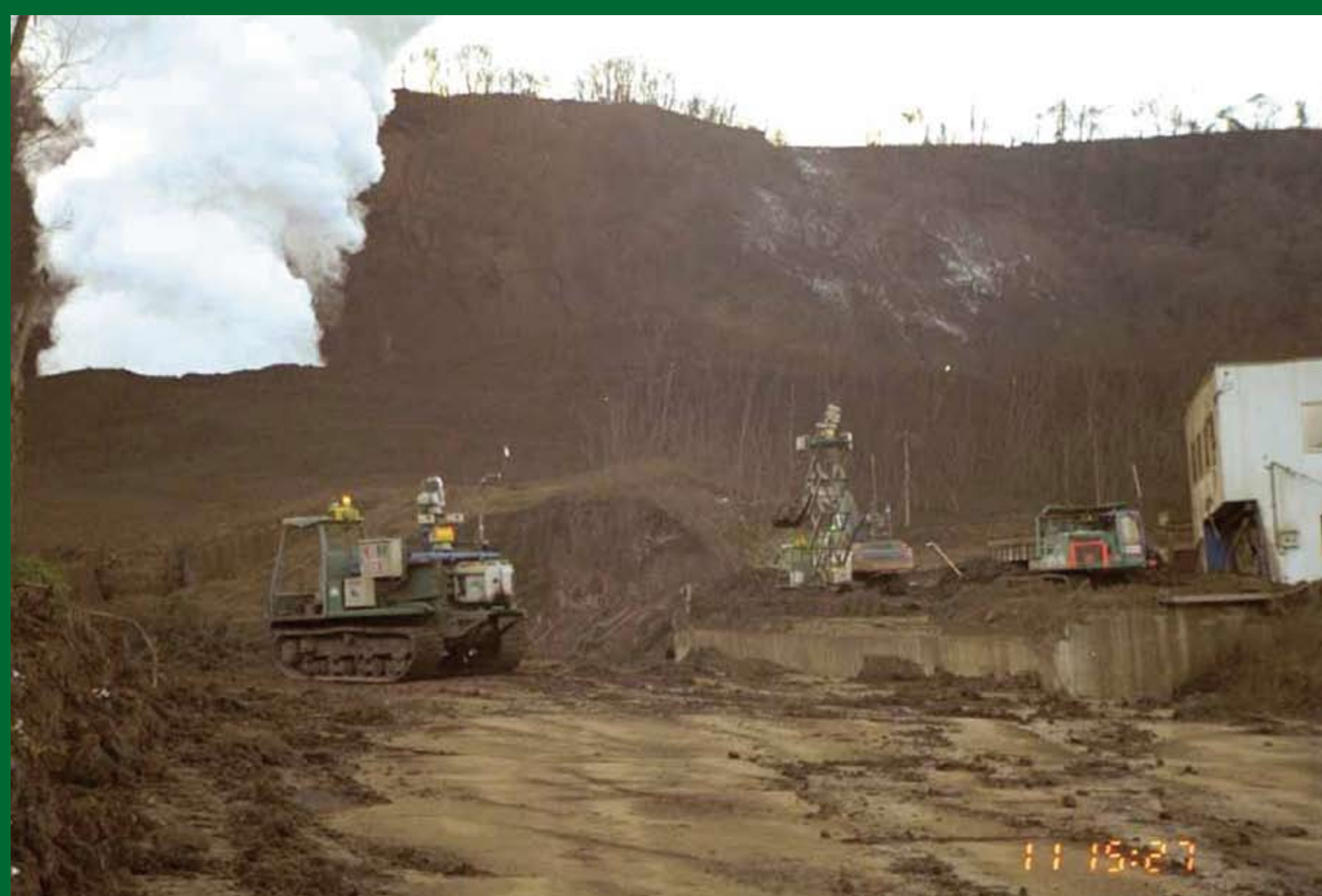
洞爺湖災害復旧 (洞爺湖温泉街)
