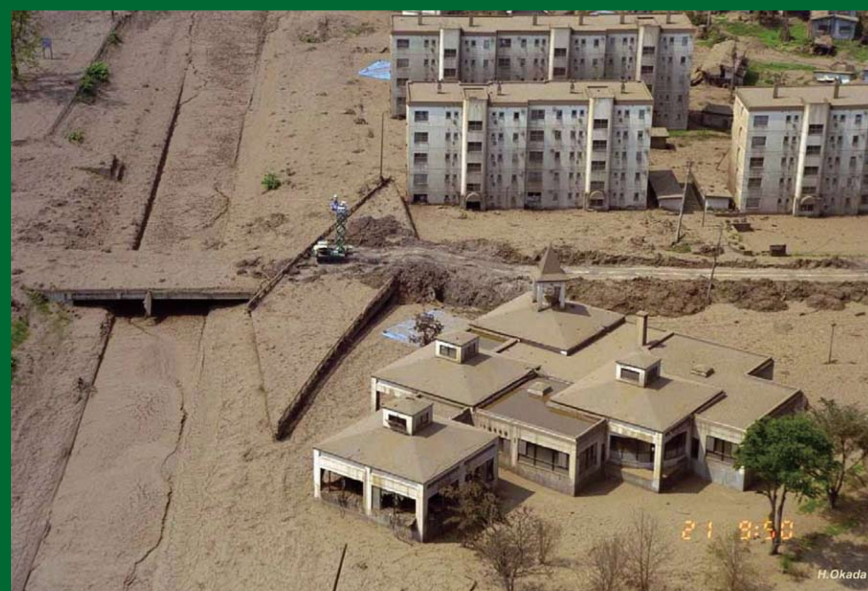
橋梁流出 (洞爺湖温泉街)
